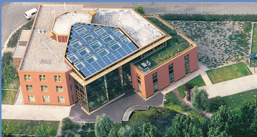
Luchtfoto van het inmiddels vijf jaar oude energiezuinige kantoorpand Thermo-Staete van adviesbureau DWA in Bodegraven.
